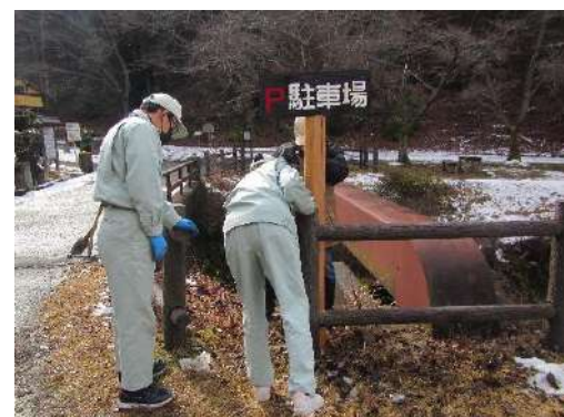
案内看板の設置
